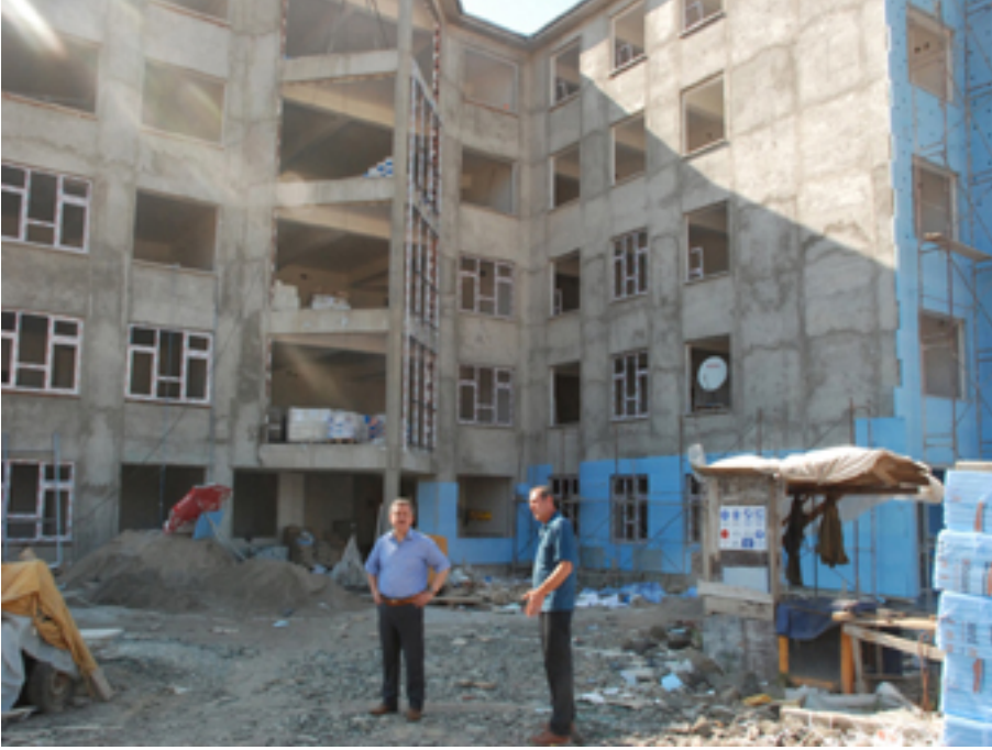
Fatsa Belediye Başkanı Hüseyin Anlayan, Dolunay Mahallesinde bulunan Dolunay İlköğretim Okulu inşaatını gezdi.
