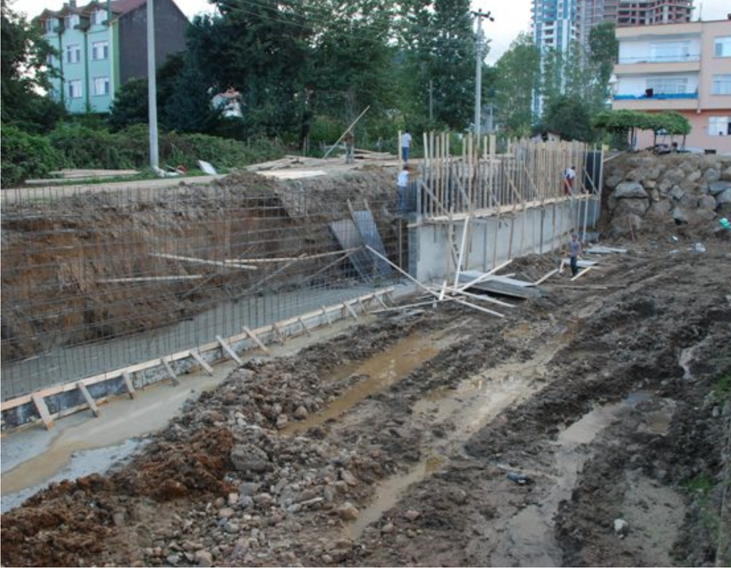
Fatsa Belediyesi alt yapı çalışmalarını ilçenin değişik yerlerinde sürüyor.
